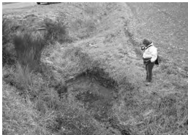
Fig. 6. — Vue de l'effondrement de décembre 2007.
