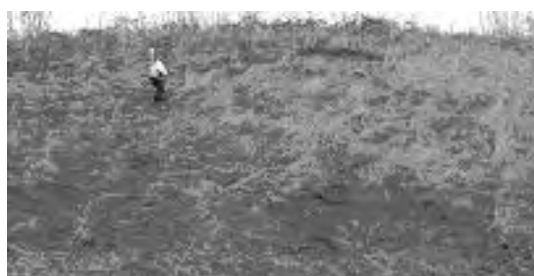
Fig. 11. — Loupe de glissement dans un talus nord du projet. Fig. 11. — Circular slide in a northern slope of the project.
