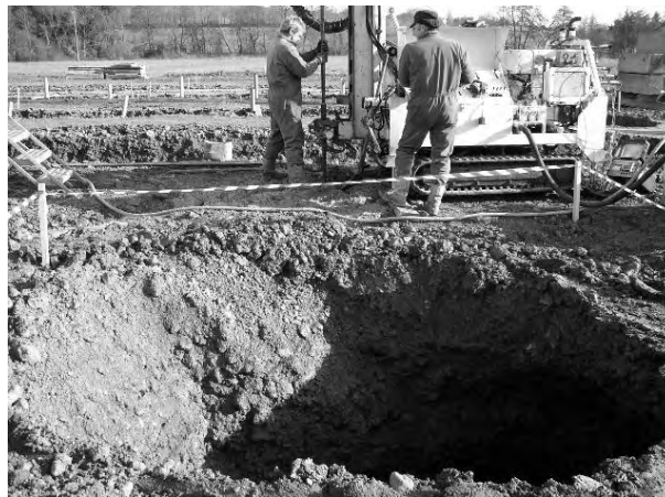
Fig. 5. — Vue de l'effondrement d'avril 2004.
