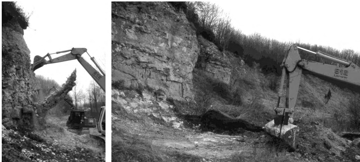
Fig. 3. — Travaux de restauration et de sécurisation des fronts de taille engagés par le Conservatoire d'espaces naturels du Nord et du Pas-de-Calais en 2000 (photos : CEN, 2000). La purge des éperons les plus dangereux (photo de gauche) a mobilisé les matériaux nécessaires au terrassement de la zone d'accueil (photo de droite) et du promontoire donnant accès pour le public à une partie de la coupe géologique.
