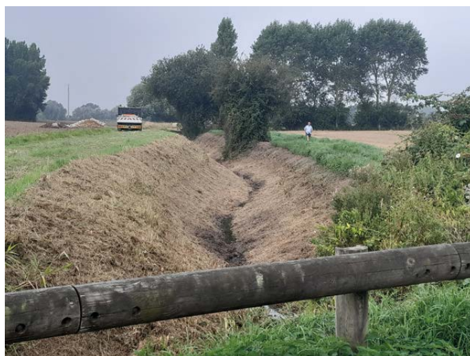
Fig. 4. - Surenretien d'une becque à l'aval de l'agglomération d'Herzele, favorisant l'écoulement et la concentration du pic de crue (été 2023). Fig. 4. – Over-maintenance of a creek downstream of the Herzele agglomeration, encouraging runoff and concentration of peak flooding (summer 2023).
