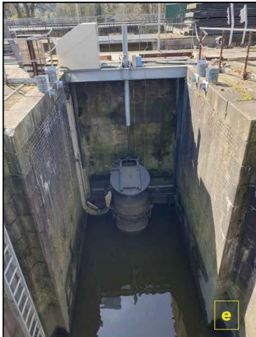
**e** Passage en siphon du canal des Moères sous l'écluse du canal de Furnes, et sa pompe de relevage.
