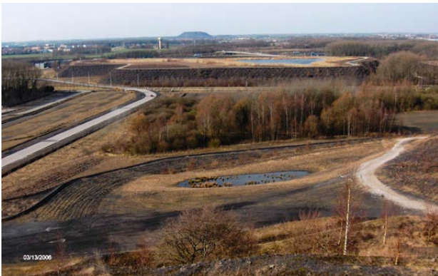
Fig. 2 – Bac à schlamms : bassin en schistes houillers dans lequel décantent les produits fins issus du lavage du charbon. Nord de la concession de Dourges. Photo F. Meilliez (février 2017) regardant vers le nord-ouest ; au fond : T98, Estevelle.
