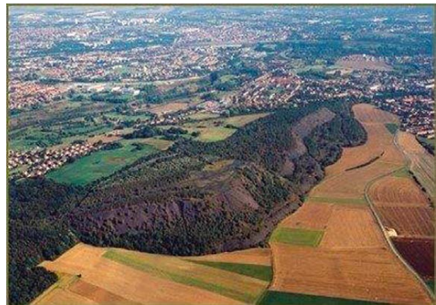
Fig. 3 – Terril de Pinchonvalles (T75) à Avion. Voir : https://eden62.fr/espaces-naturels-a-decouvrir/les-espaces-naturels-sensibles-2/terril-du-pinchonvalles/
