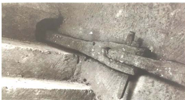
Fig. 11 – Deux éléments de la ceinture de renfort du triforium (boucle, fourchette et clavettes).
