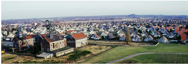
Fig. 1. — Photo prise (novembre 2008) depuis le sommet d'un terril, montrant les diverses générations de cités minières à Oignies (62), et les installations de surface de la fosse 9-9bis (concession de Dourges).
