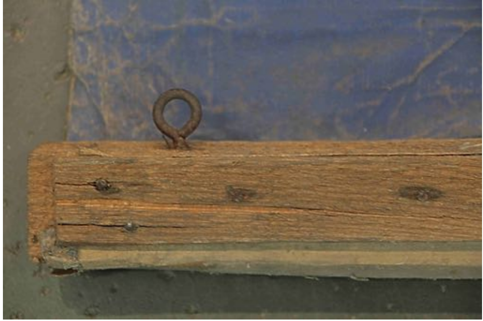
Figure 2. Détail du système d'accrochage par tasseau de bois. Photographie Eric Ouley, 2020.
