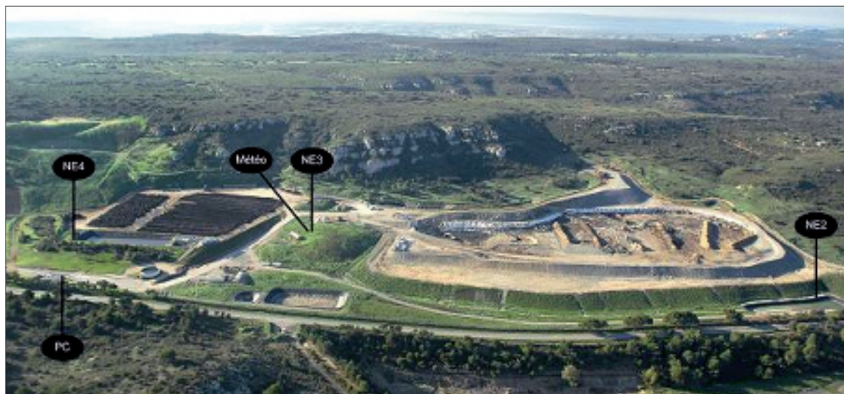
Figure 6. Localisation du système ODOWATCH sur le site. ODOWATCH system localization.
