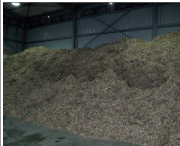
Silo à combustibles.
